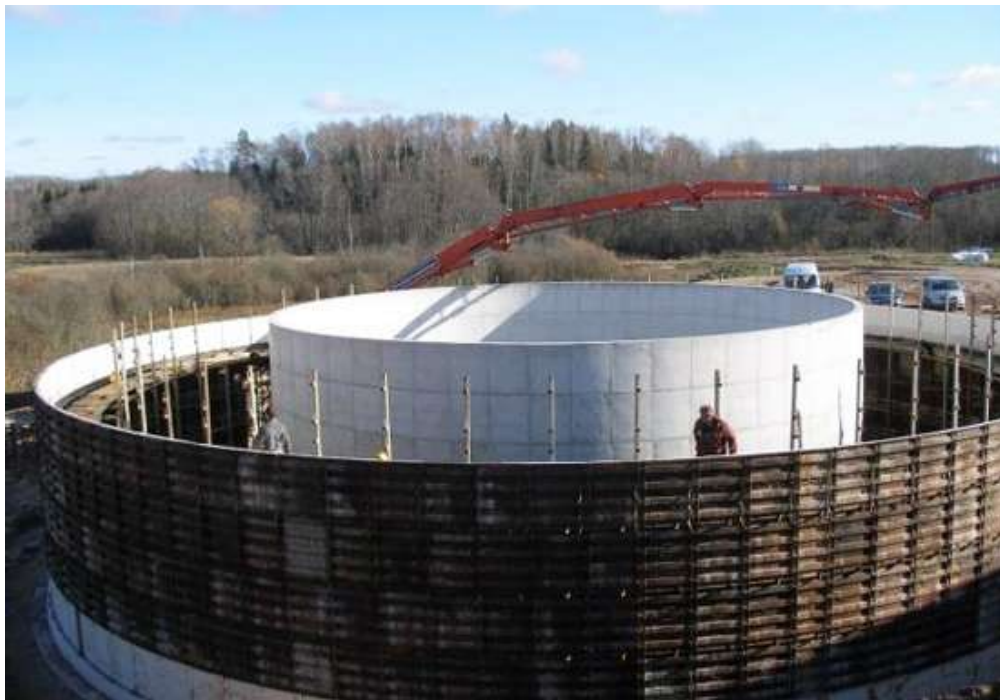
Рис.3.11. Будівництво біогазової установки на свинокомплексі в селі Копанки Івано-Франківської області
