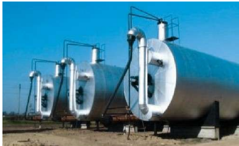
Рис.3.5. Зовнішній вигляд біогазової установки
