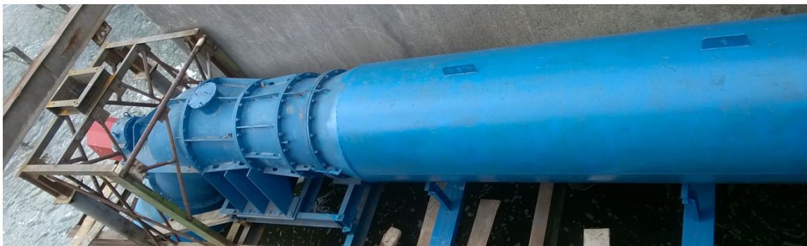
Рис. 1. Гідротурбіна Т-90 ТОВ «Мінігідро» на Бережанській мікроГЕС в процесі монтажу
