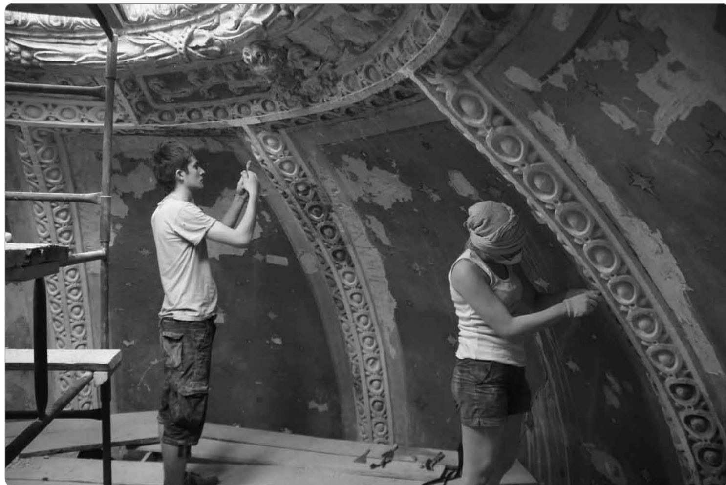
Kaplica Ukrzyżowanego Pana Jezusa w trakcie renowacji, fot. J. Smaza
