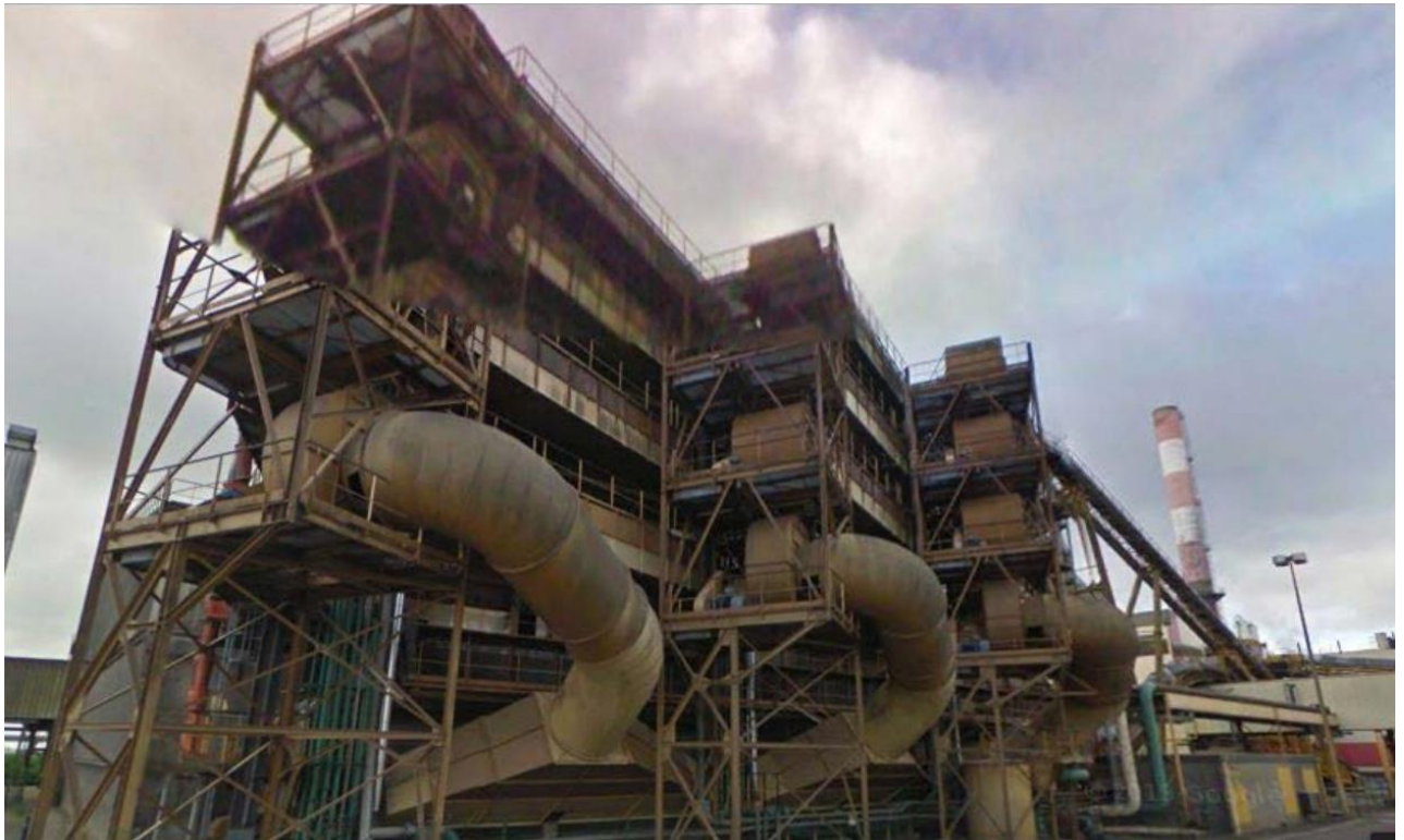
Рис. 1.3.4 Конвективна стрічкова сушарка для жому теплою утфельної пари на цукровому заводі Артенне [Artenay], Франція
