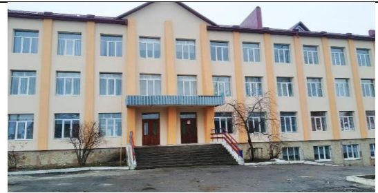
Рис. 3.20 Утеплення фасаду і заміна вікон Золотниківської ЗОШ І-ІІІ ступенів
