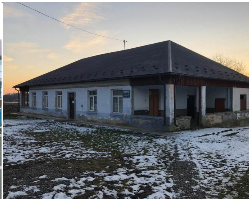
Рис. 3.15. Капітальний ремонт в с. Сапова Тернопільського району
