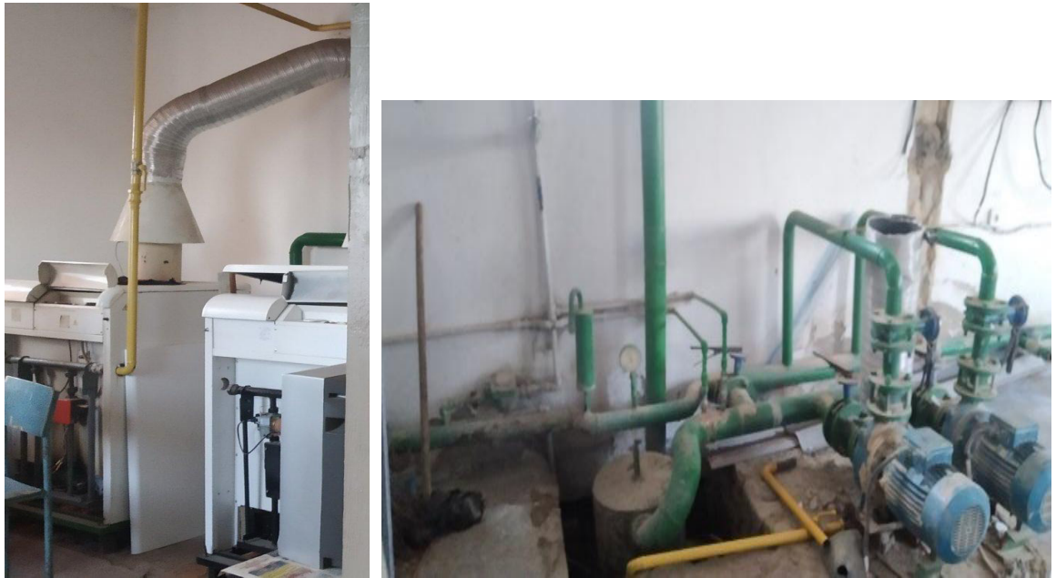
Рис. 3.18. Капітальний ремонт котельні (заміна котлів) Золотниківської ЗОШ І-ІІІ ступенів
