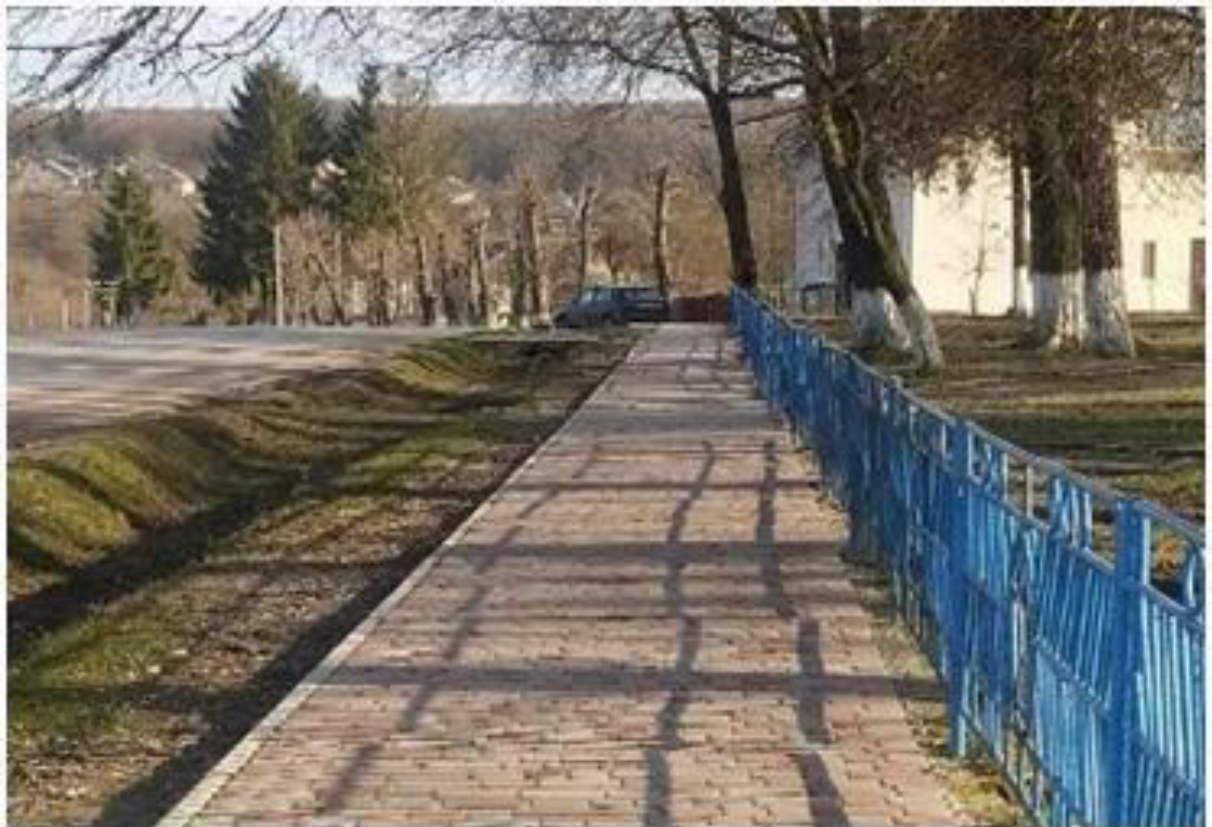
Рис. 3.17. Поточний ремонт тротуарів
