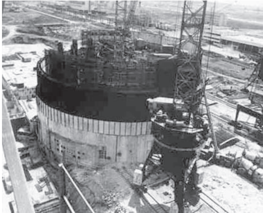
Монтажні роботи на реакторному відділенні Південноукраїнської АЕС
