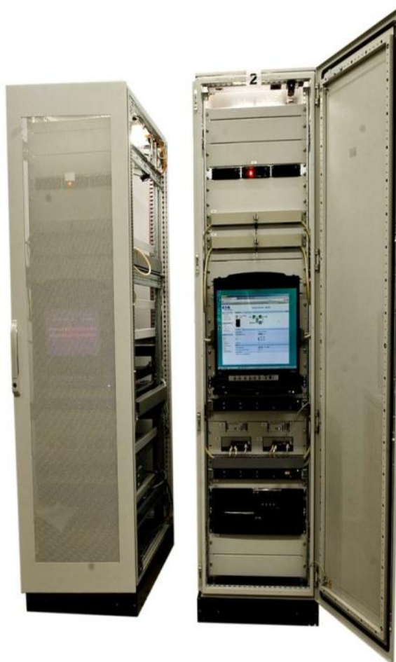
Рисунок 3.3 – Шафа управління АСУ ТП
