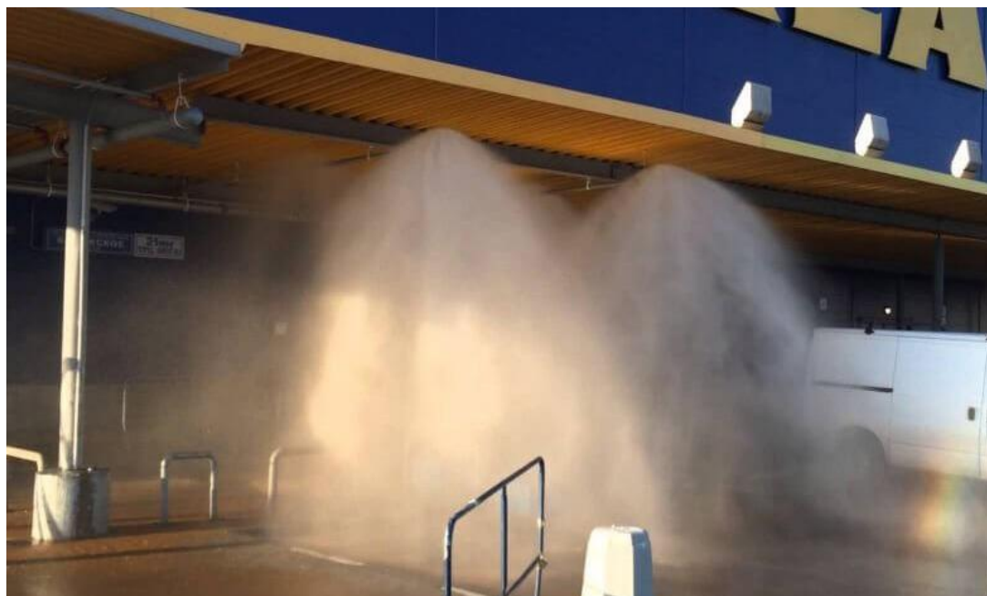
Рисунок 2.5 - Вигляд системи пожежогасіння з використанням водяного туману
