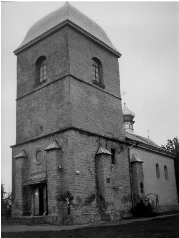
Фото 5. Церква Воздвиження Чесного Хреста, м. Тернопіль
