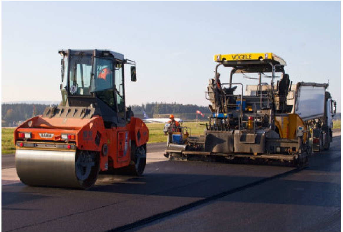
Рисунок 1.8- Процес вкладання асфальту асфальтоукладачем
