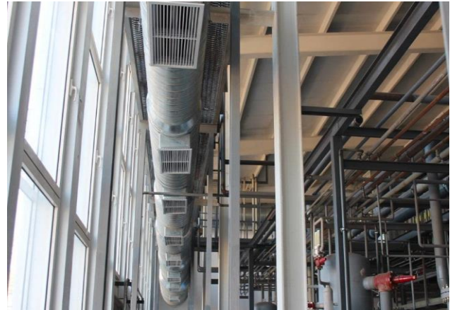
Рисунок 1.5 - Система подачі енергоносія та теплообмінники АСО
