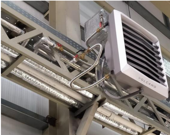
Рисунок 1.5 - Система подачі енергоносія та теплообмінники АСО
