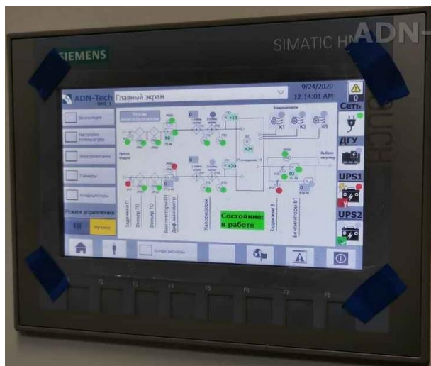
Рисунок 1.4 – Модуль центрального управління та диспетчеризації SCADA-системи клімат-контролю
