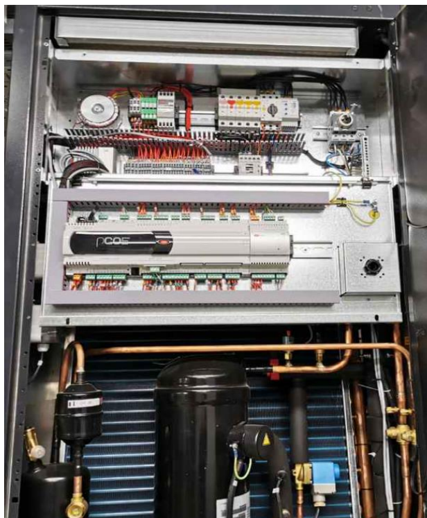
Рисунок 1.6 – Загальна компоновка АСУ, головна шафа управління системи
