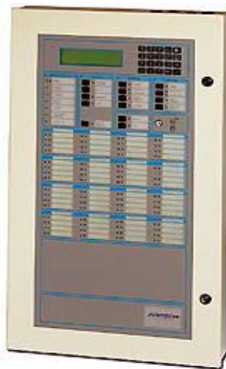
Рисунок 2.1 Демонструє адресно-аналоговий приймально-контрольний прилад Aritech серії FP2000
