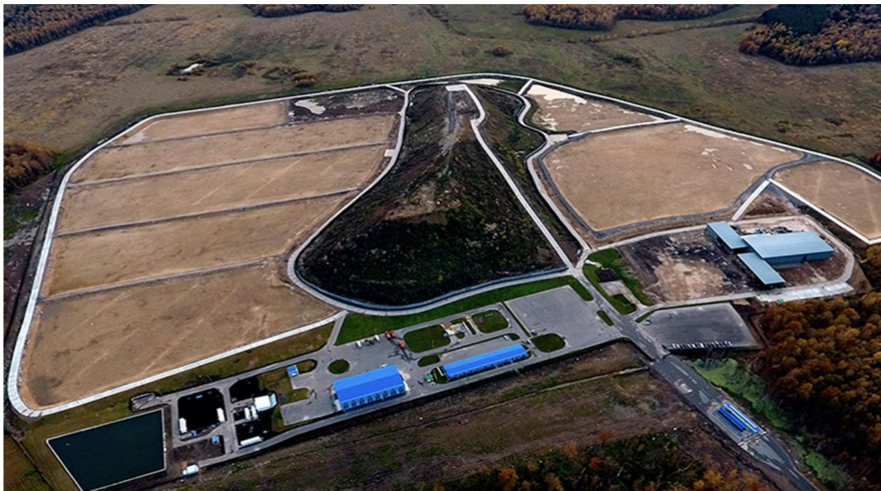
Рис. 8. Загальний вигляд біоенергетичного комплексу в експлуатації
