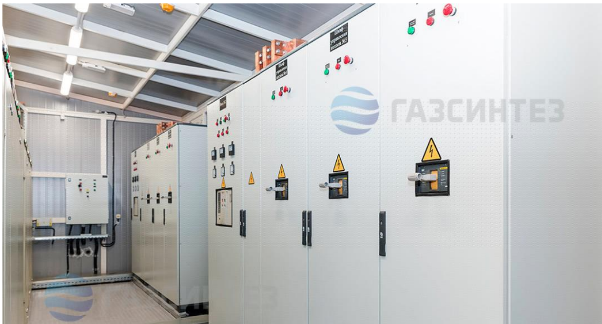
Рисунок 1.1 – Загальний вигляд оснащення електокотельні.
