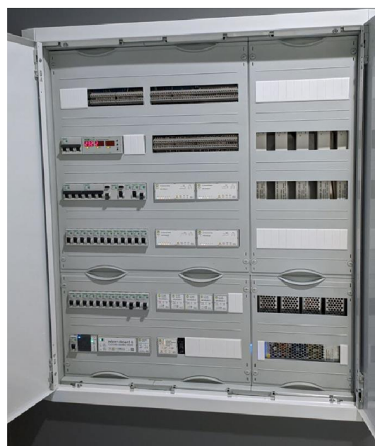
Рисунок 2.19 – Загальний вигляд щита керування автоматизованої системи освітлення промислових цехів
