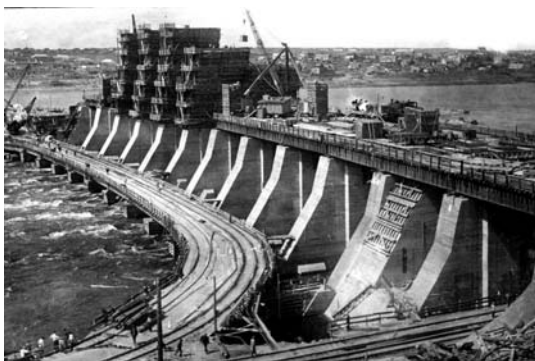
Зведення Дніпровської ГЕС, яке розпочалося в 1927 р.
