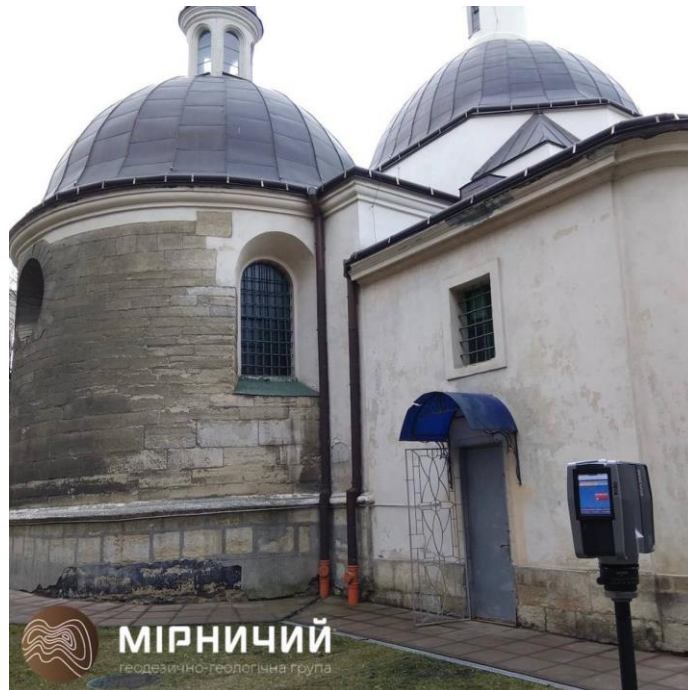
Рис. 3.6. Встановлений лазерний сканер на станції
