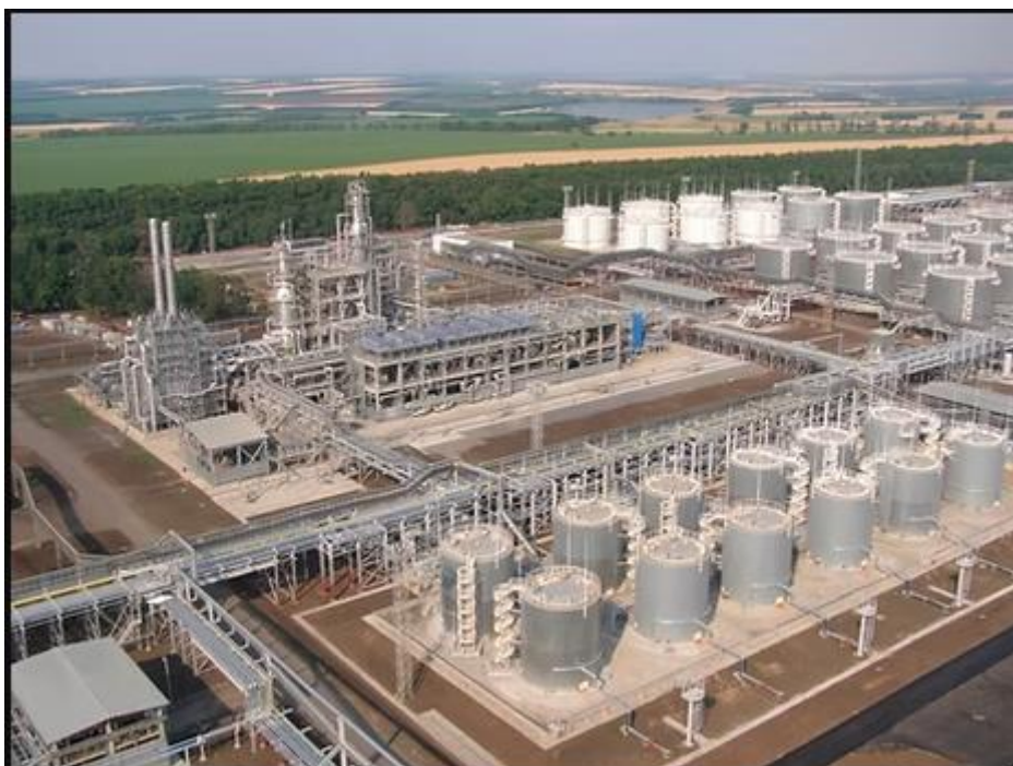
Рисунок 1.1 – Загальний вигляд резервуарного парку нафтопродуктів.
