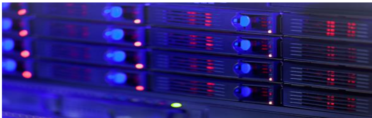
Рис. 1. Дата-центр (центр обробки даних)
