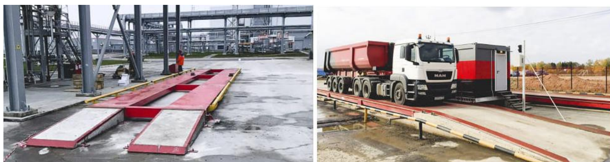
Рисунок 1.7 – Встановлення АВ над поверхнею землі
