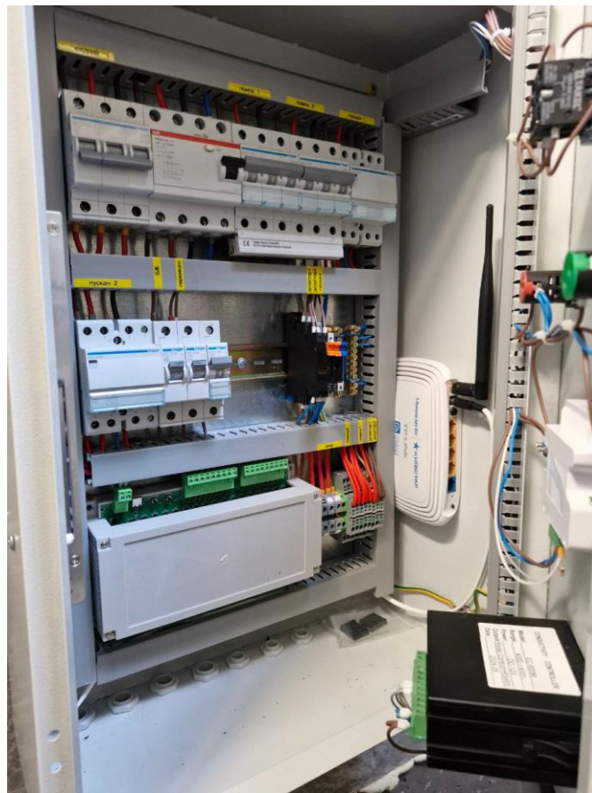
Рисунок 3.2 – Вигляд змонтованих компонентів у щиті керування
