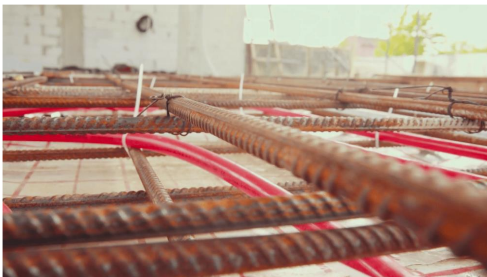
Рисунок 1.3 - Система підігріву підлоги на автомийці самообслуговування
