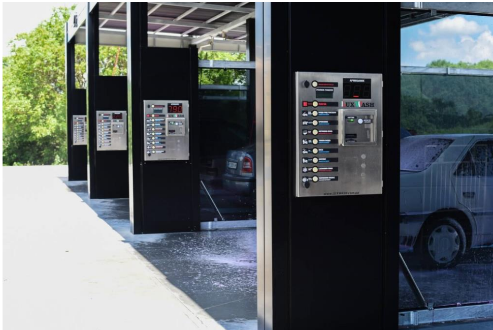
Рисунок 1.2 - Миючий пост автомийки самообслуговування
